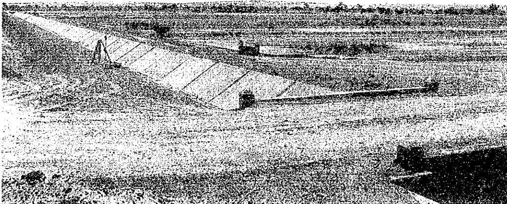
コンクリート用水路
