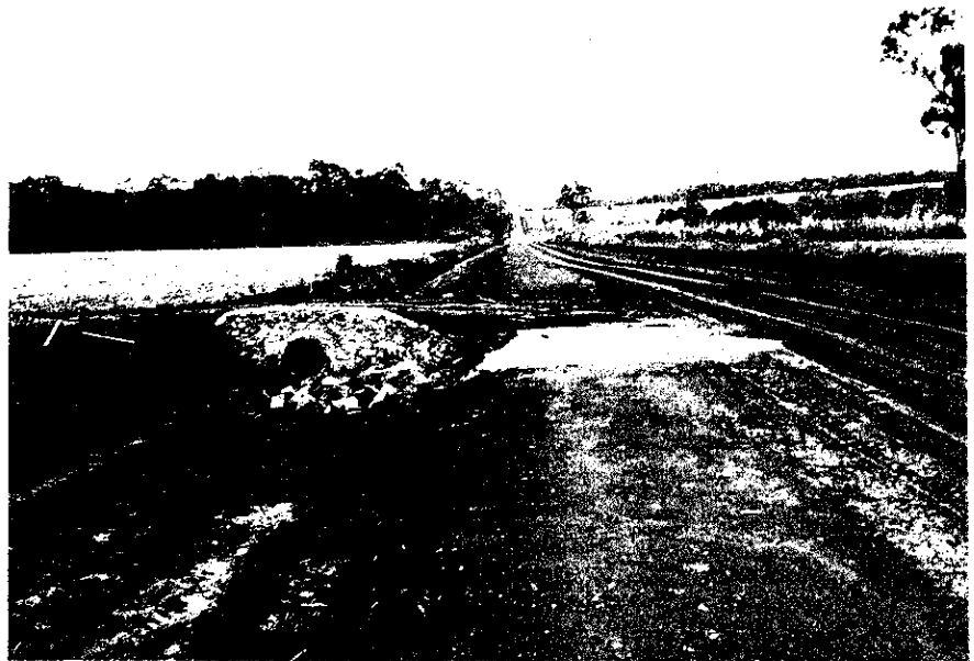
イグアス移住地内の路面 改修工事（幹線道路） ▶
