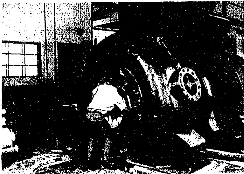
フランス水車おまひ発電機
