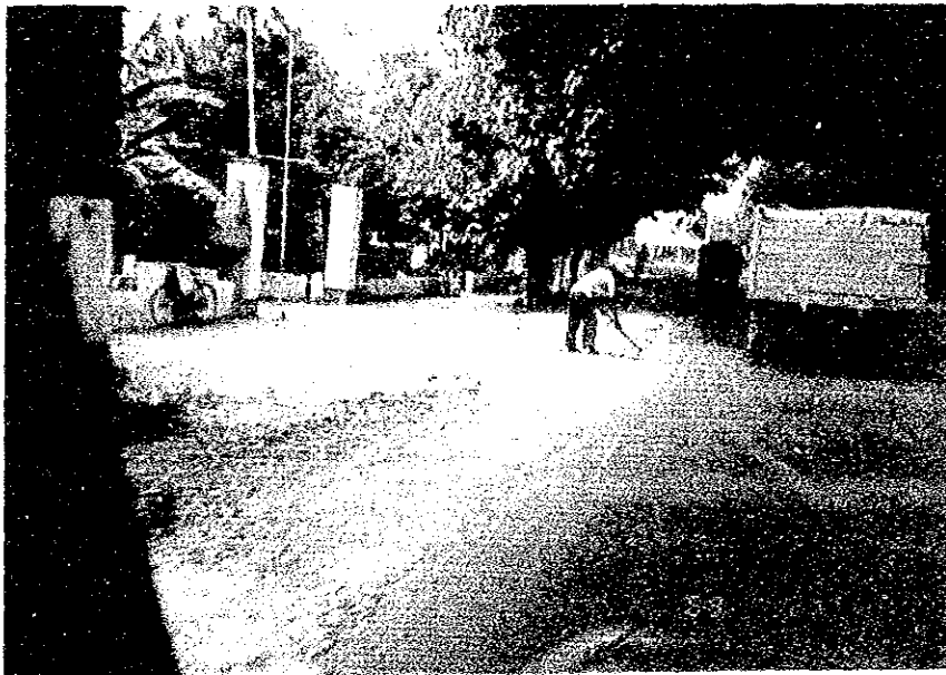
クリアン=モジョクルト間（現道補修状況・路肩）
