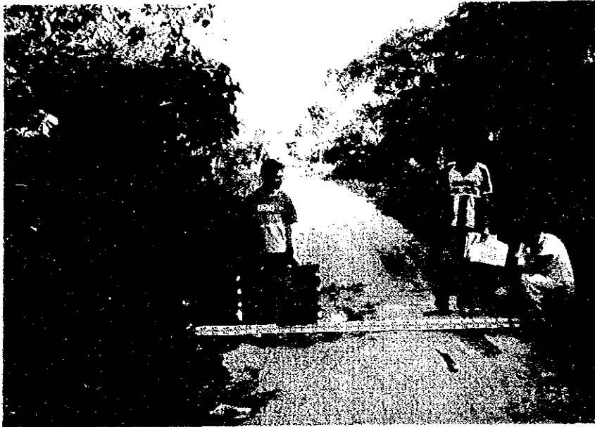
Lugar de construcción para ampliar y mejorar el camino
