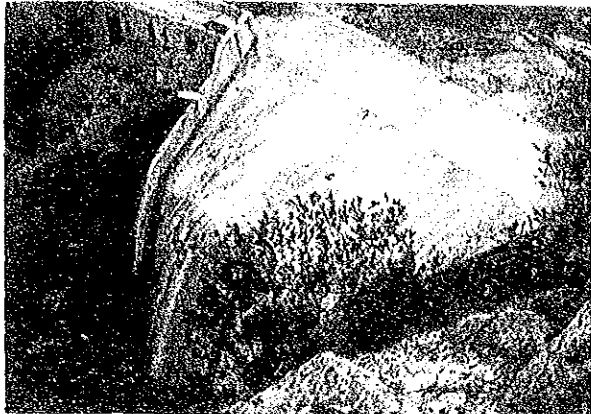
余水吐呑口部の状況。設計洪水量が 188\text{ m}^3/\text{s} ( 1/25 年確率)であり通水能力の不足が指摘 されている。
