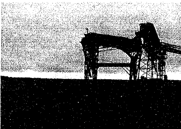
穀類等24万トンの貨物を取り扱うビジェッタ港。 サイロと岸壁とは、ベルトコンベアで結ばれて いる
