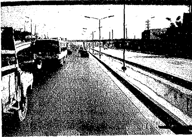
◀国道31号のUターン路 国道31号の10車線区間については横断構造物がないため、このようなUターン路が設置されている。
