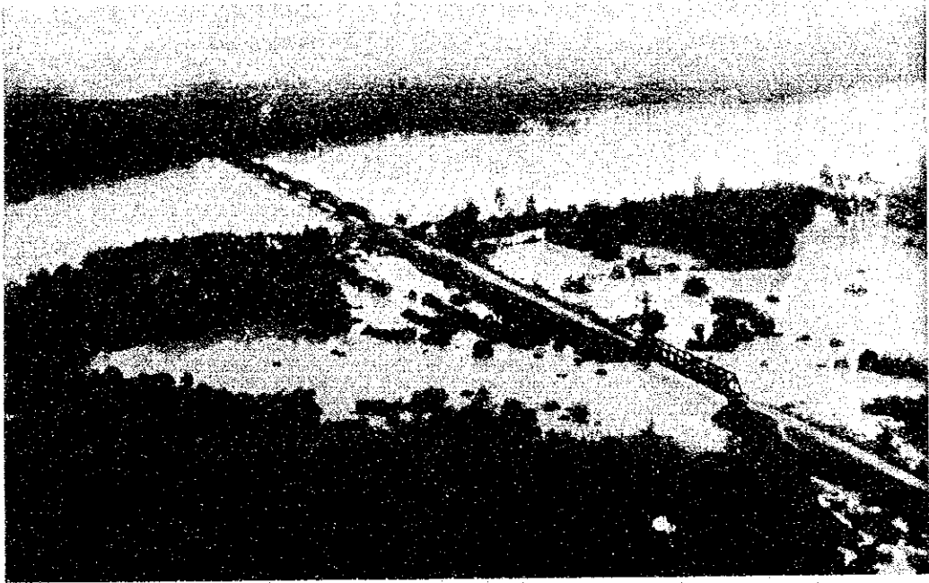
ギルマード橋 (1988年11月26日)
