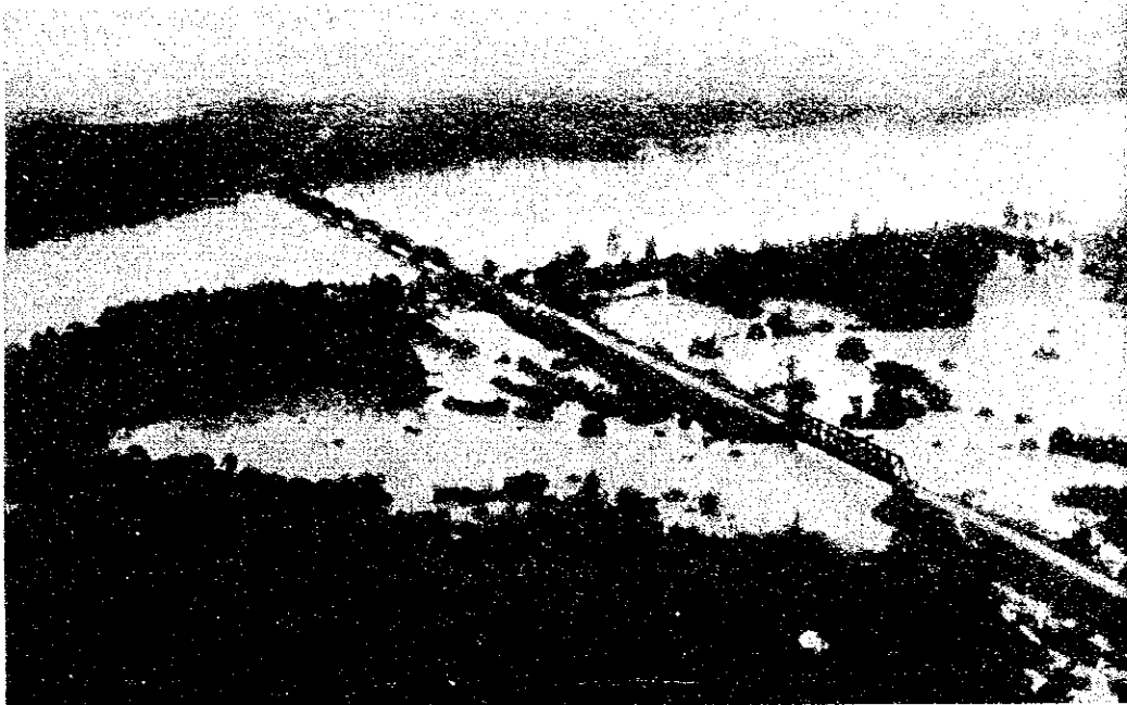
ギルマード橋 (1988年11月26日)
