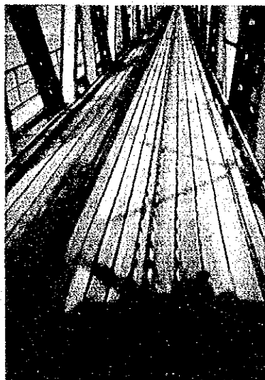
写真C 同一平面上を走行する鉄道・自動車併用橋
