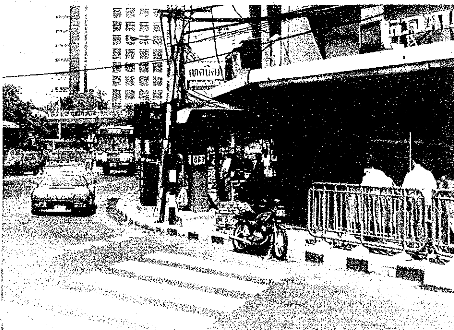
スリウォン道路との交差点に ある信号制御施設
