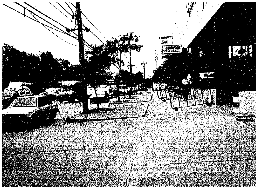
ラマ四世道路（西進）現況 車道および路側
