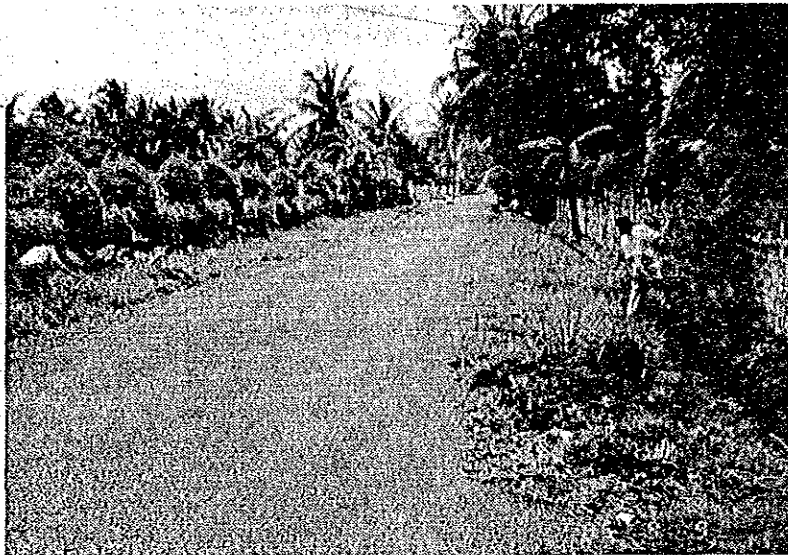
マニラ市住宅街で 道路幅員調査
