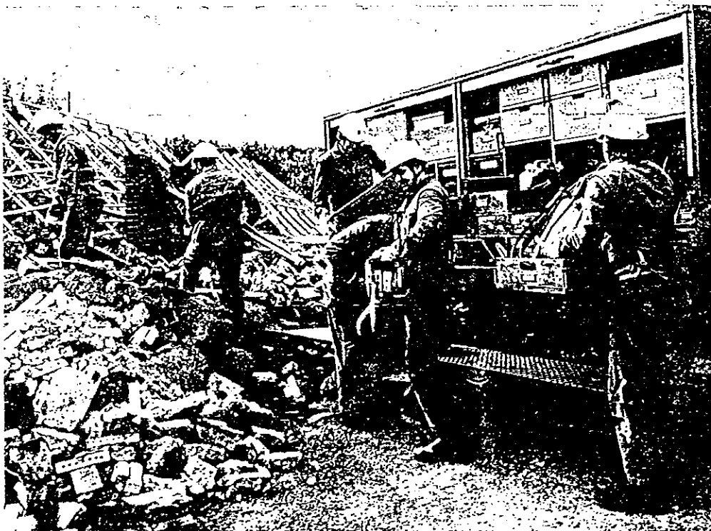
THW-Helfer der Gerätegruppe eines Bergungszuges bei einer Einsatzübung.
