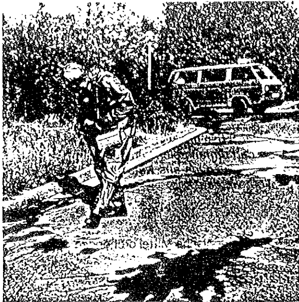
Rechts: Dekontaminierung einer Straße in 2 m Breite mit dem Dekontaminations-Mehrzweck-Fahrzeug (DMF).
