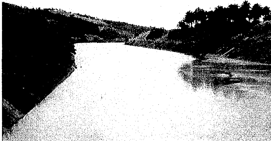
上部導水路 第III期の増設まで対応可能 ( Q_{max} 360 m^3/S )
