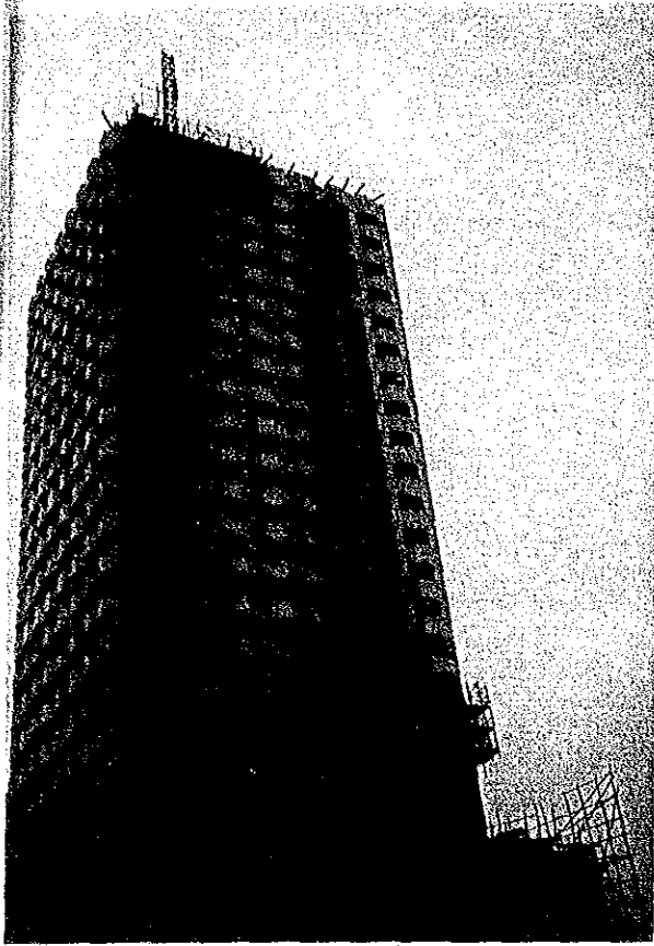
建設中の専利局新庄舎
