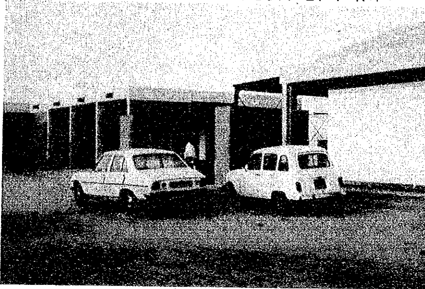
TERRAIN DONNANT SUR MER DE LA COMPLEXE DE NOUAKCHOTT
