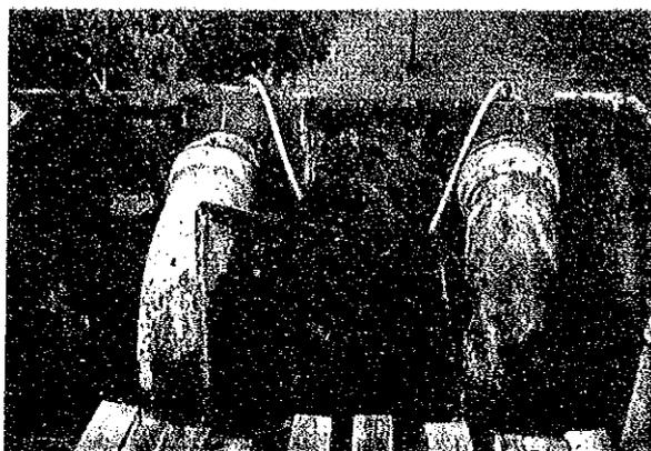
流水管取付部。構造物の腐蝕、老朽化、配管類のメンテナンス不足が見られる。
