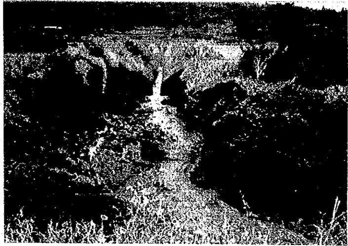
既設幹線排水路
