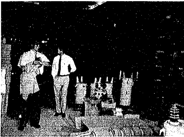
INAPA 修理工場の内部
