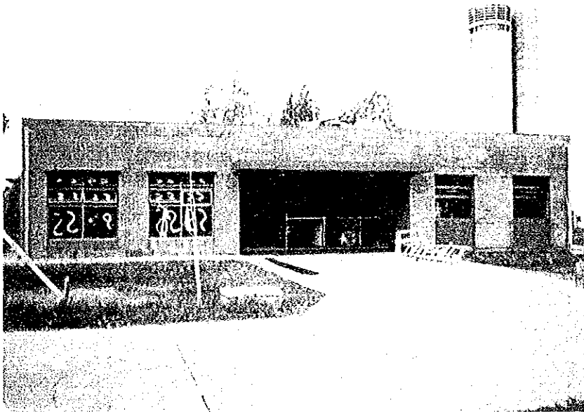
Project サイト (建築中)
