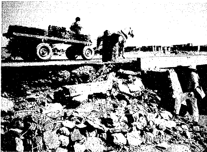
写真 5.2.9 崩壊している取付護岸
