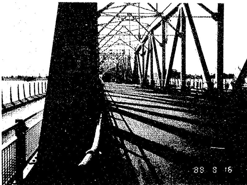
写真 3.3.7 白ナイル橋現況写真 (1)
