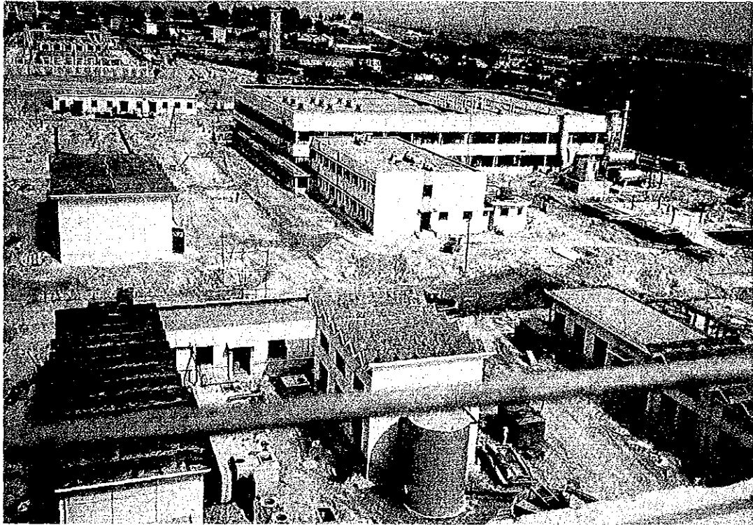
燕山樹脂応用研究所（建設中）
