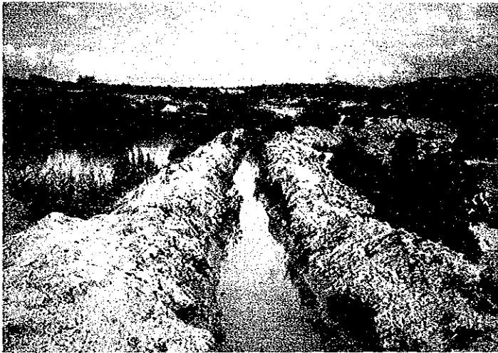
溜池の堤頂上の水路 (侵食谷を水路が横断するため)
