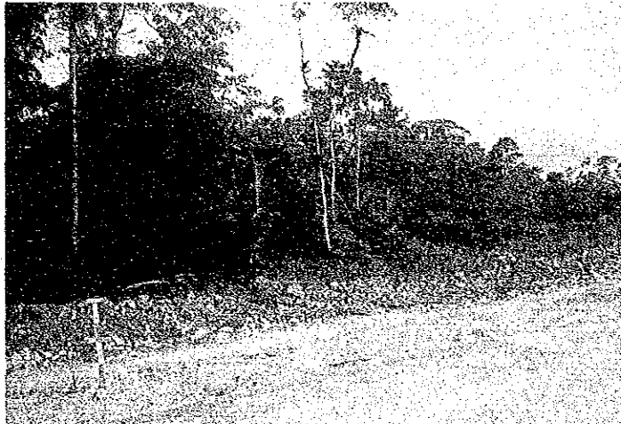
ドミトリー建設 予定地
