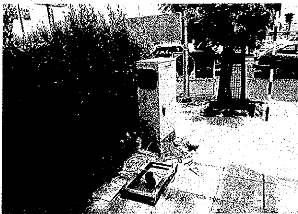
ジェッタ（旧内務省前）の信号制御機 手前の架枠は非常用発動発電機設置用
