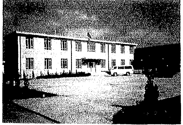
〔天津市乳牛育種改良センター〕 ① 事務所棟
