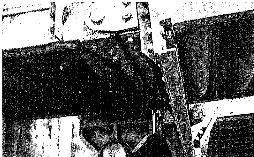
歩道部腐食状況
