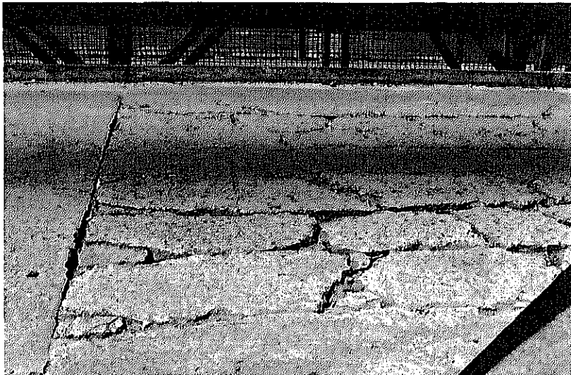
橋台ひびわれ
