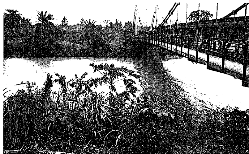
架け替え計画対象地点。 現橋の直下流部。 (アクラ側より見る)
