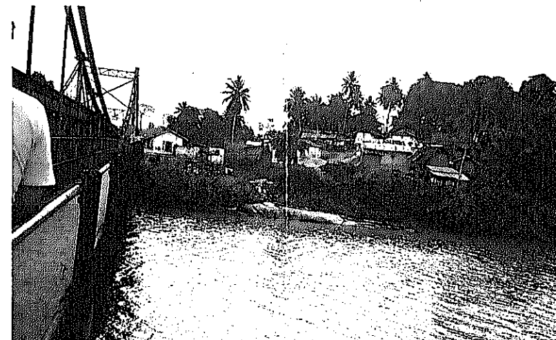
架け替え計画対象地点。 現橋の直下流部。 (タコラディ側より見る) アクラ側アバットメント 付近に岩の露頭が観察さ れる。
