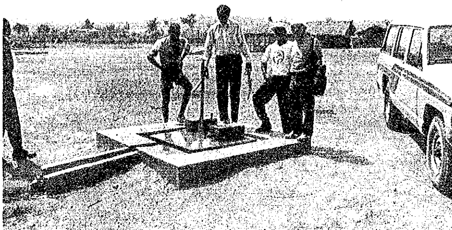
Forage avec pompe à pédale construit par le Japon la fois précédente.
