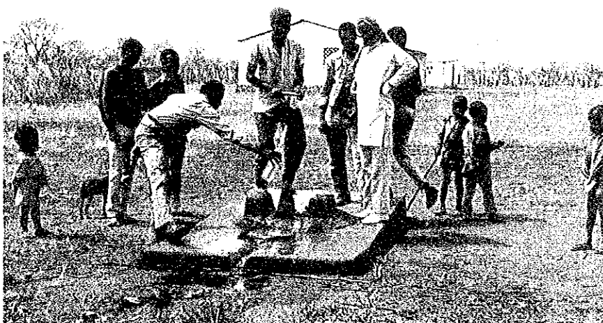
Forage avec pompe à pédale construit grâce à l'aide du SIDA.
