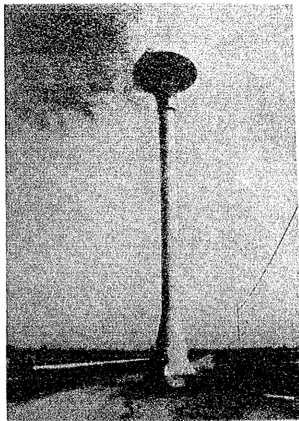
チュラボーン科学コンプレックス給水塔
