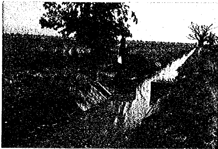
パイロットファーム二次水路
