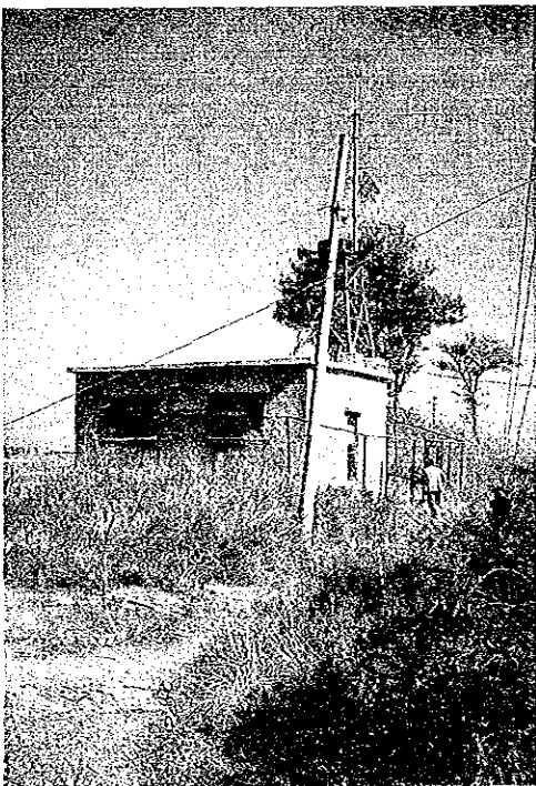
写真下：完成した水質観測局舎
