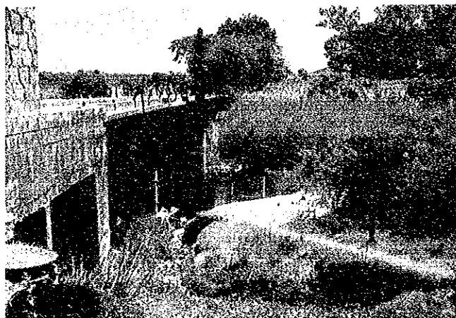
▲SMITH BRIDGE G/S (Kafue River)
