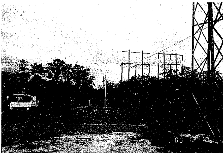
既設リロングウェ B変電所 132kV 送電線引込口
