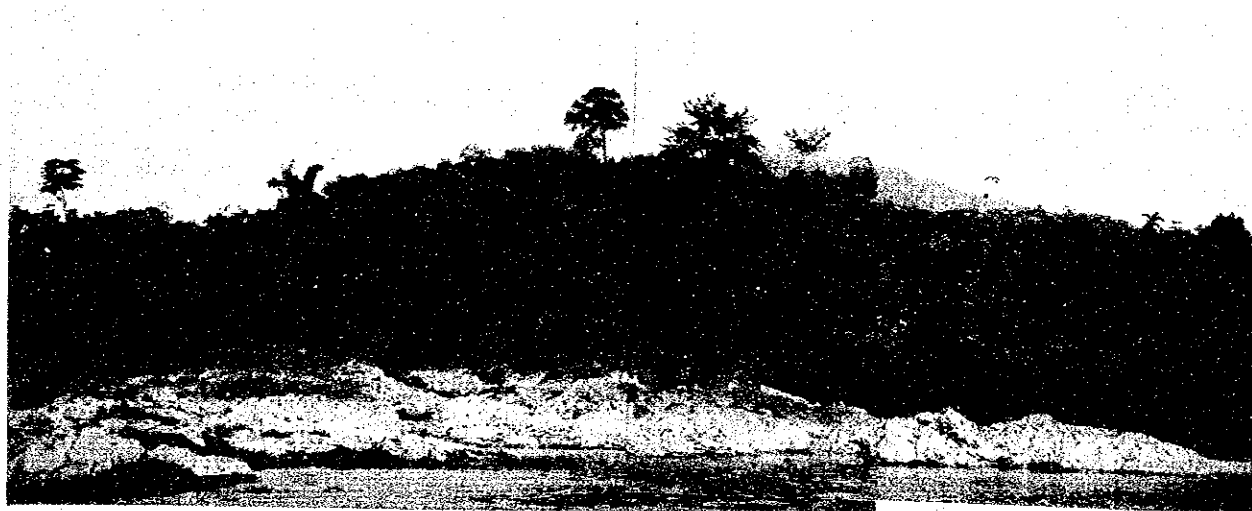
左岸を望む。河床部に岩盤露頭 (EL.30 m) 頂部標高 EL.110m
