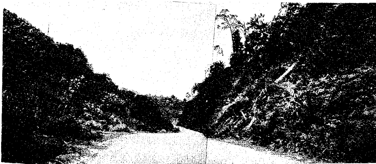
下流側より望む。中央は原木運搬道路。
