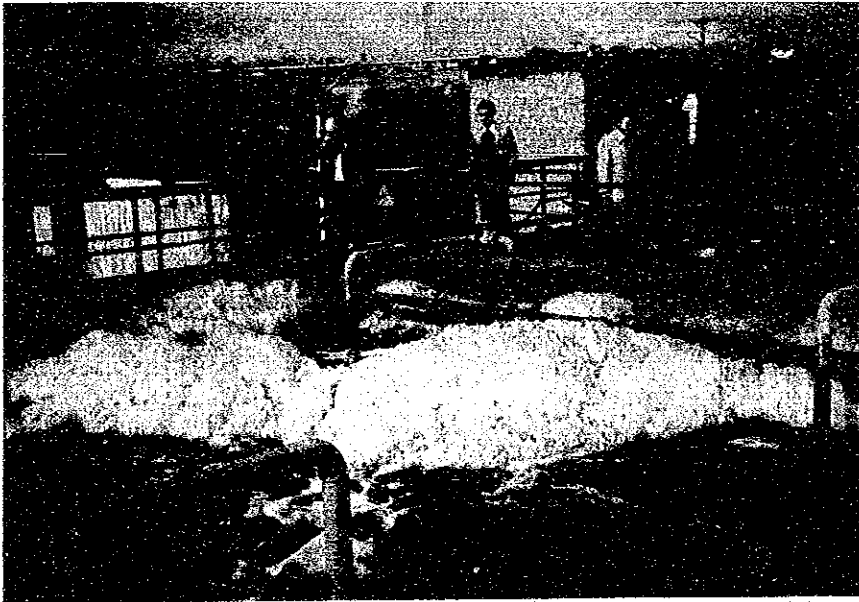
② コークス工場排水処理場（曝気槽）
