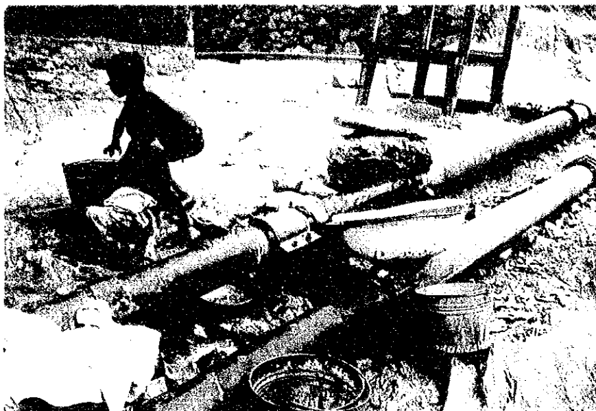
既設配水管（ゾーンⅡ）
