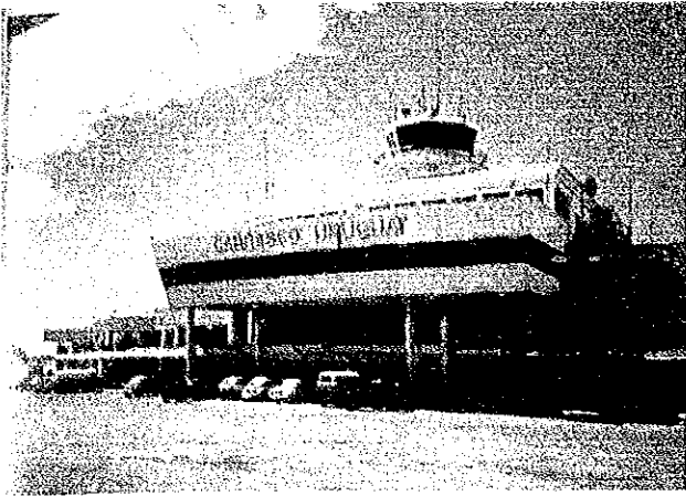
▲ エプロン側から見たターミナルビル
