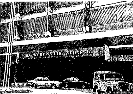
RRI ジャカルタ局舎
