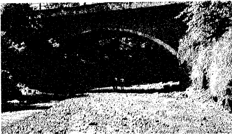
Photo - 14 Reference Point Cikunir Bridge (S. Cikunir)
