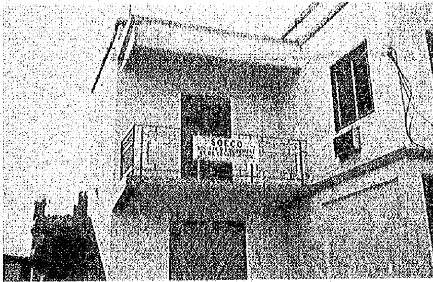
事務所建物 外部仕上 壁 : モルタルペンキ仕上 建具 窓 : ジャロジー (上) アルミサッシュ (下)
