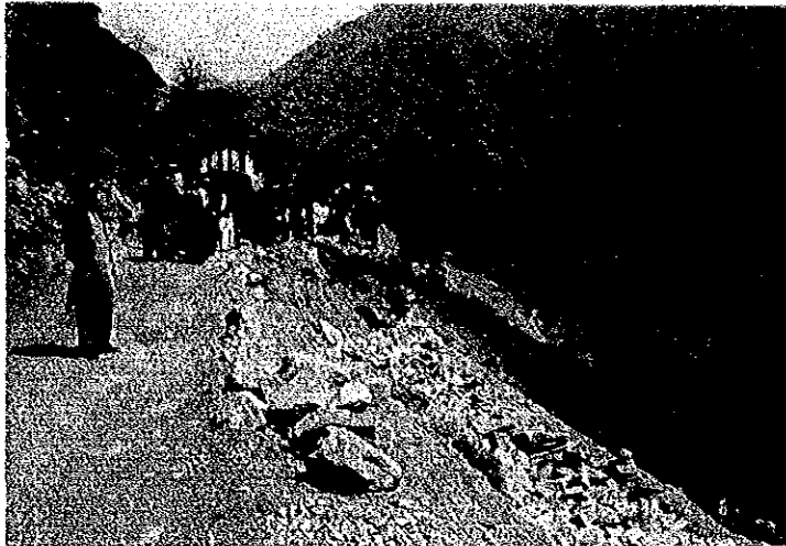
ジャングラバールにおける道路状況。幹線は一応舗装されているものの支線道路は整備が不十分で農産物運搬及び生活上の大きな障害となっている。
