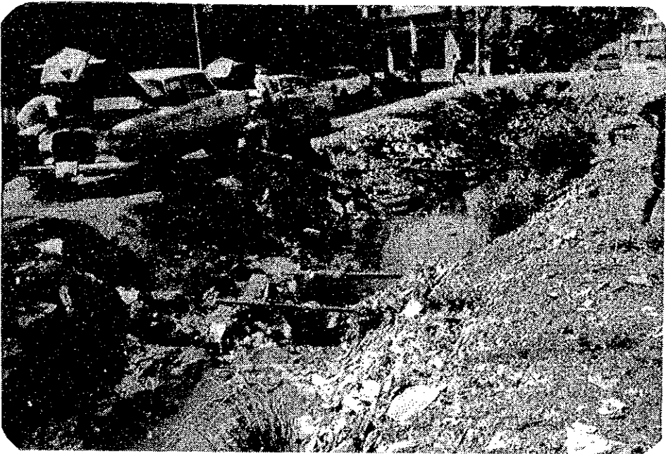
写真2.10 汚水が放流される排水路（ファクース）
