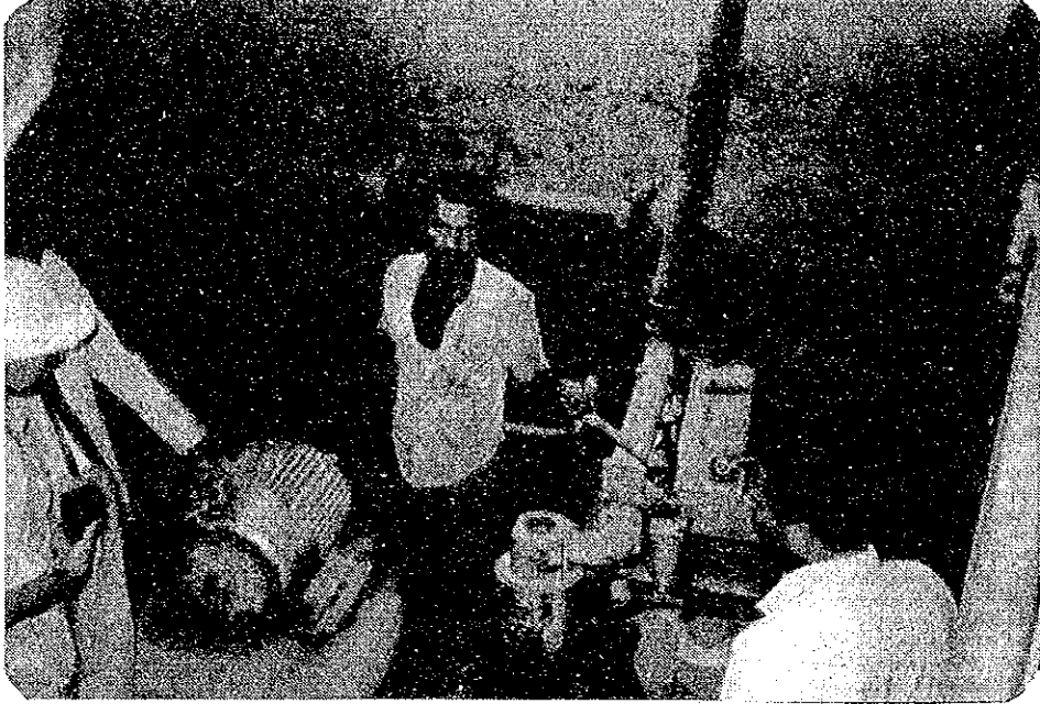
写真2.9 既設ポンプ場（ビルベイス）
