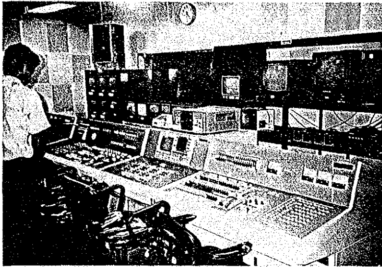
副調整卓全景
