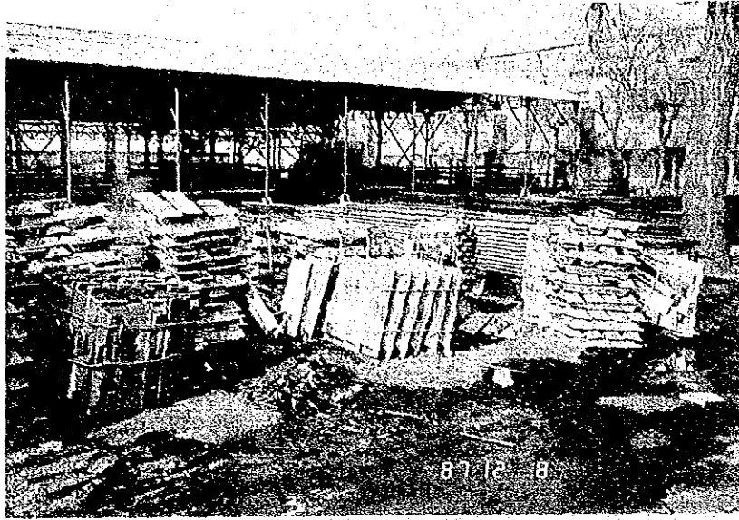
写真3-1 鋼材、資材置場
