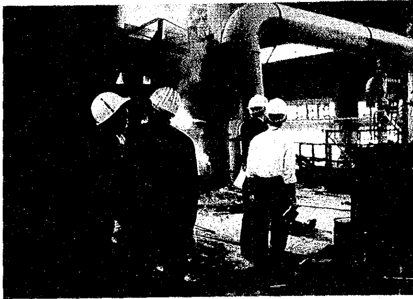
写真-3 電気炉前状況
