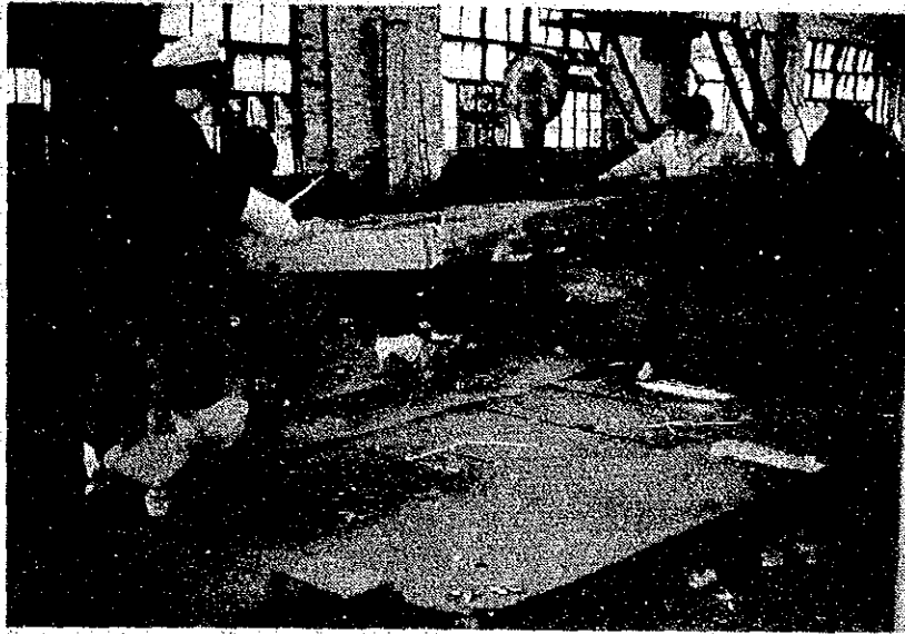
図V-2-35 下部フレームの回転溶接治具
