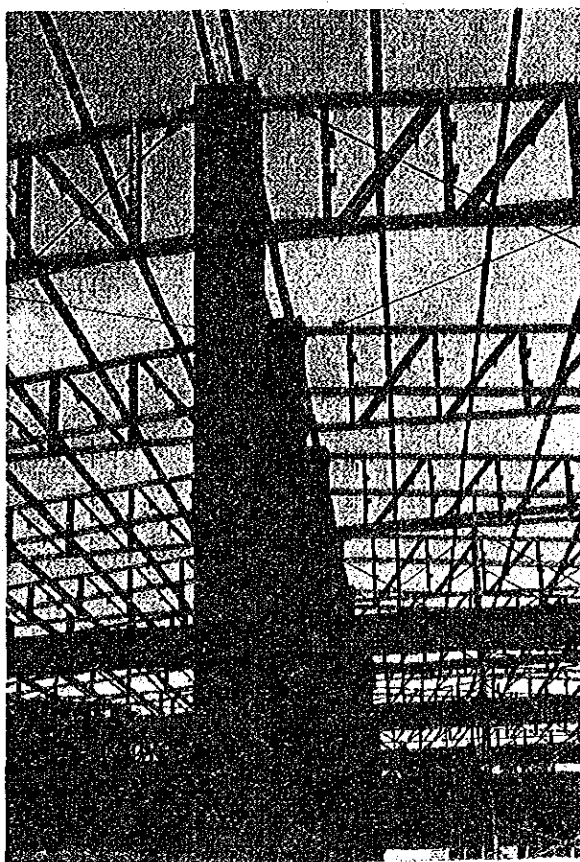
ホニアラ市内建設現場
