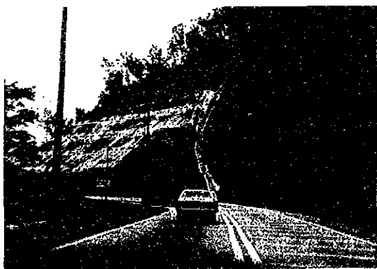
高い切上のり面が多く、しばしば崩壊する。 KUALA LUMPUR KARAK 間
